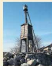
明治6(1875)年建造の「出島(でげじま)の灯台」。第二室戸台風で倒壊寸前となり、昭和48年に復旧された
